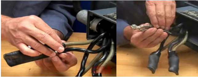
Motor con cables de salida
