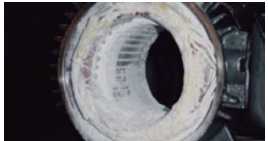
Figura 6. Exceso de contaminación interna
